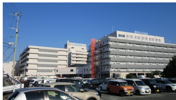
写真右の建物が 2025 年秋に竣工したリハビリテーションセンター棟です
